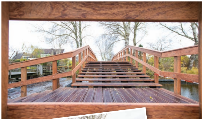
Doorkijkje brug 'De Reiger'
