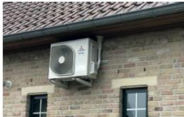
Warmtepomp aan gevel in zicht
