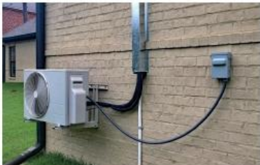
Losse kabels bij warmtepomp
