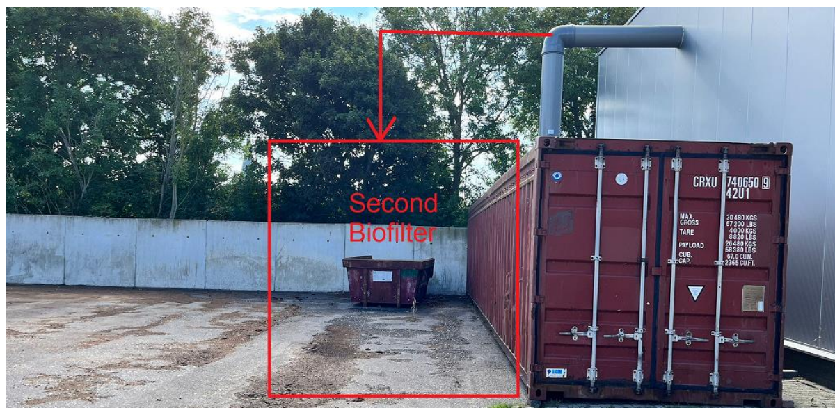
Figuur 4 – Biofilter naast de mest- en co-productenopslag met locatie tweede biofilter
