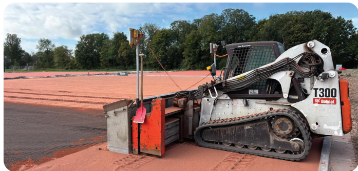
Aanbrengen roodzand tennisbanen Foto: Frederik Kamstra
