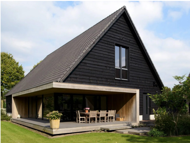
Gevels in donker hout met lichte accenten en geïntegreerd terras Bron: La-architecten.nl
