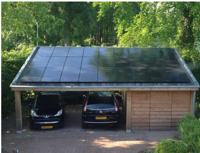
Zonnepanelen op een bijgebouw
