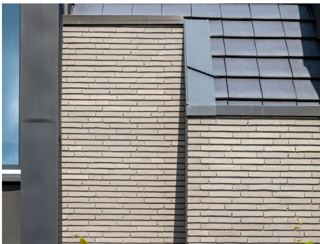
Gevels in lichte baksteen en donkere accenten van plaatmateriaal (metaal) Bron: Rodruza.nl
