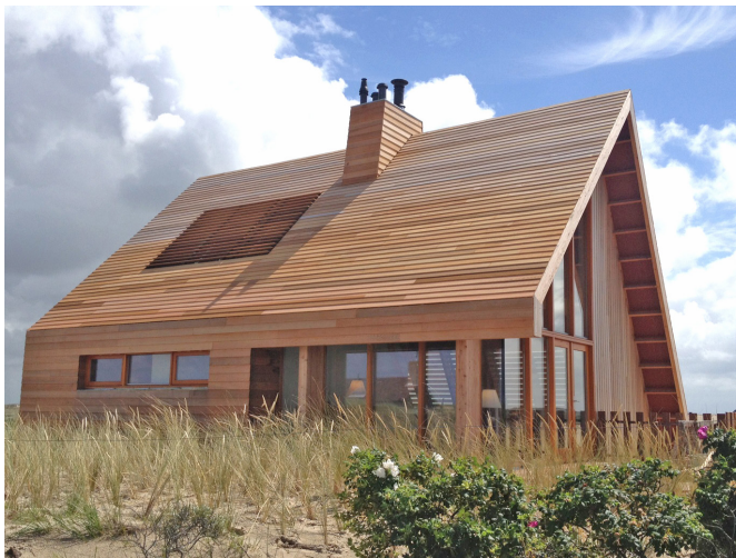
Gevels en dak in licht hout met een overstek aan de voor- en achterzijde Bron: zantmanarchitecten.nl
